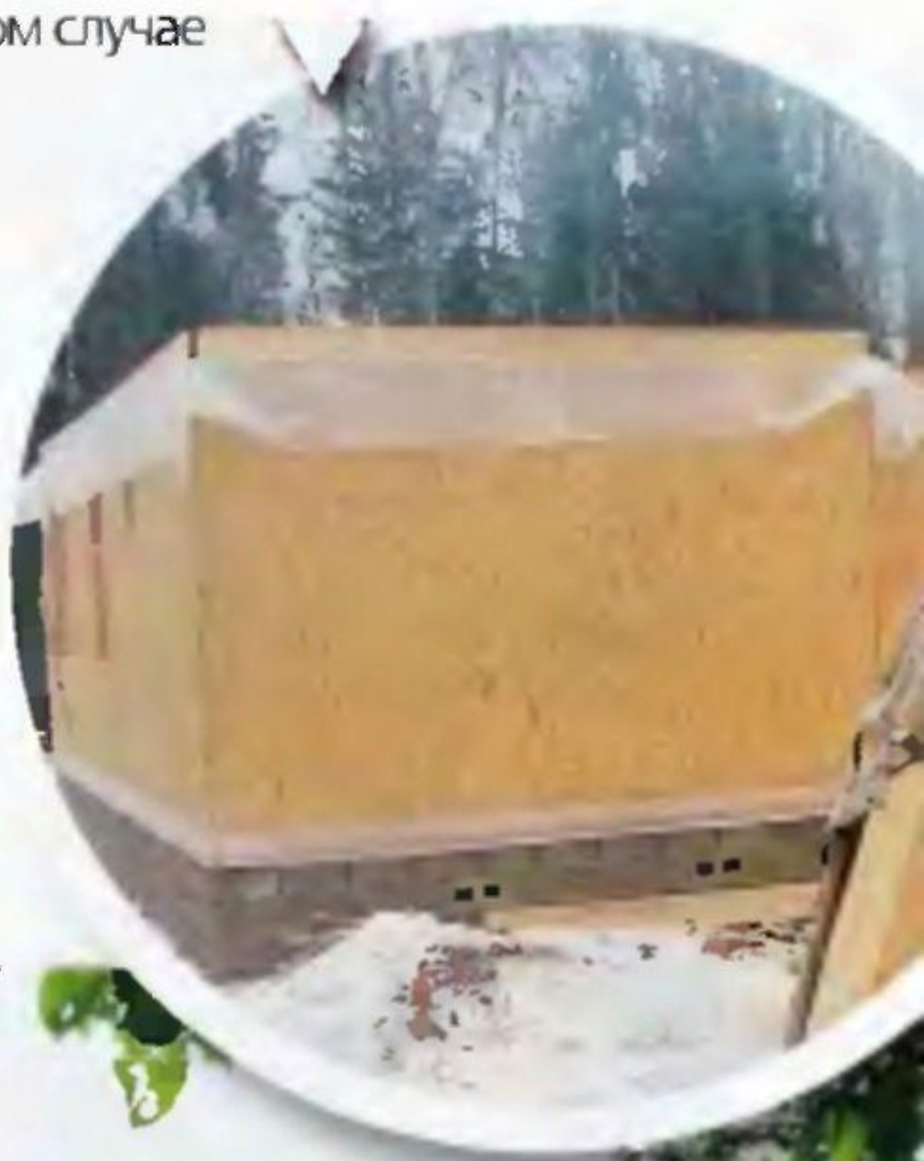
Коробка 1 этажа каркасно-панельного дома (ф. «Стройдром»)
