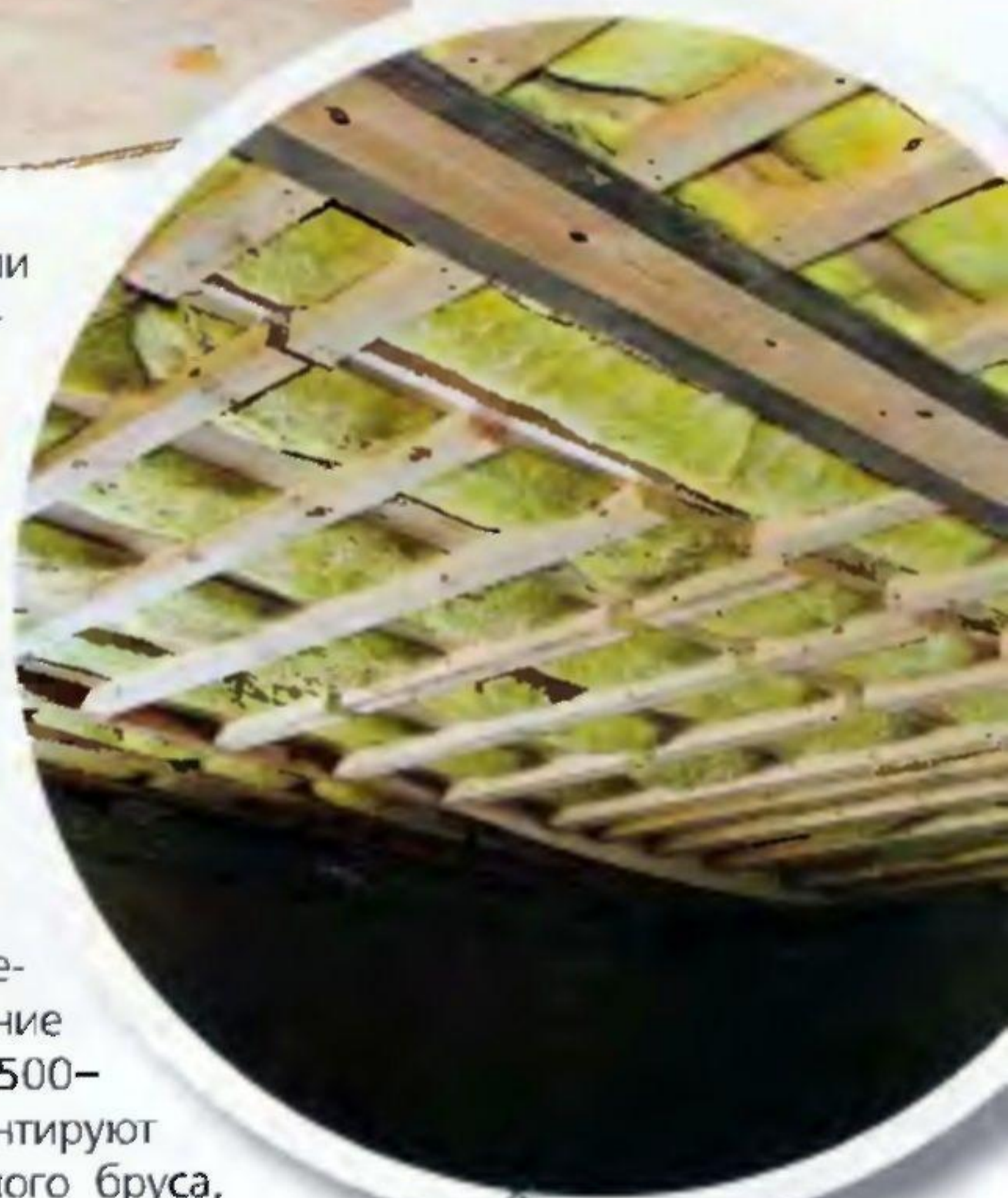
В перекрытии стекловата выполняет функцию звукоизоляции (ф. Peter Haus)
