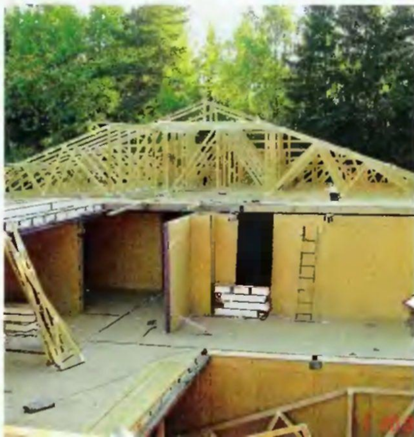
Строительство каркасно-панельного дома по технологии «Экспан» (ф. «Город мастеров на ВВЦ»)
