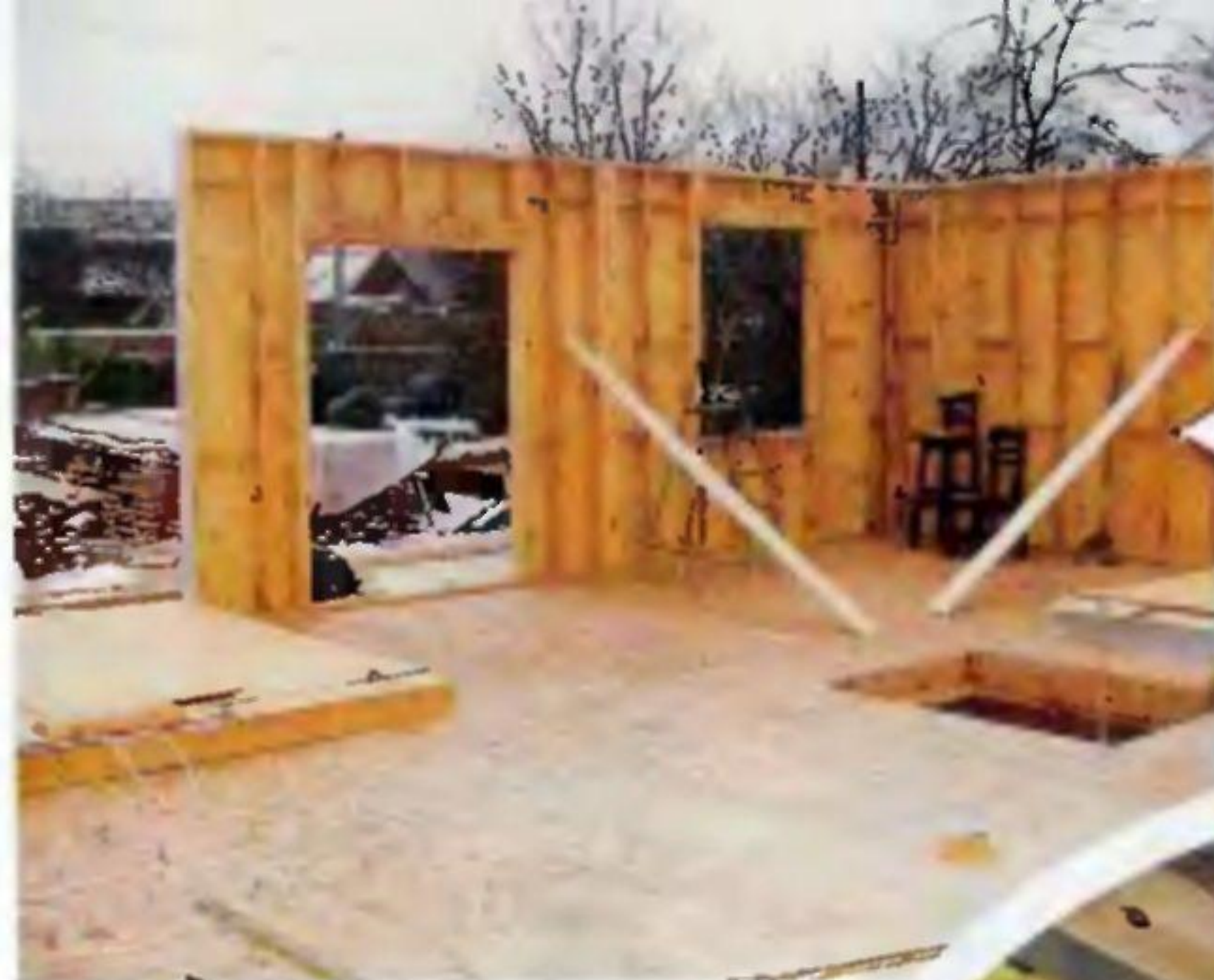
Начало установки стеновых панелей в каркасно-панельном доме
