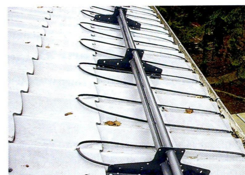
Система «Теплоскат» (ССТ) на основе саморегулируемого кабеля
