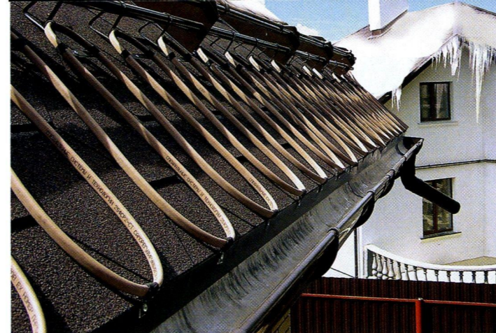
Система «Теплоскат» (ССТ) на основе саморегулируемого кабеля
