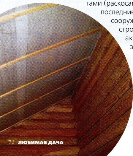
Утепление кровли (ф. «ГарантСтрой»)
