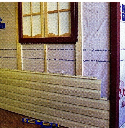
Облицовка стены виниловым сайдингом Kaysan
