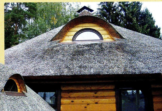
3. Последний этап – очистка и подрезка покрытия
