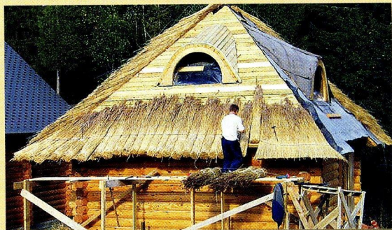
1. Укладка первого ряда снопов по карнизному свесу
