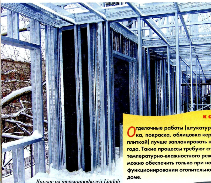
Каркас из термопрофилей Lindab
