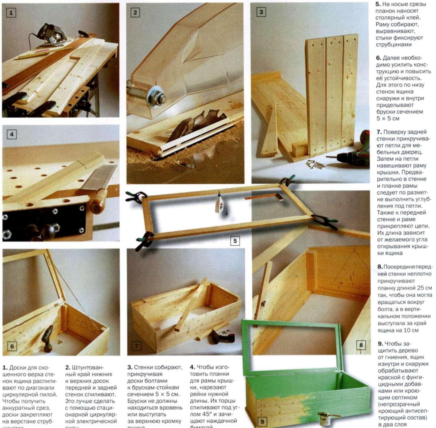
**1.** Доски для склонного верха стенок ящика распиливают по диагонали циркулярной пилой. Чтобы получить аккуратный срез, доски закрепляют на верстаке струбцинами
