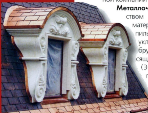
Медная кровля (ф. «НБК-строй»)
