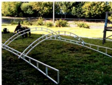
Кривая монтируется на земле
