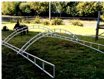
Крышка монтируется на земле
