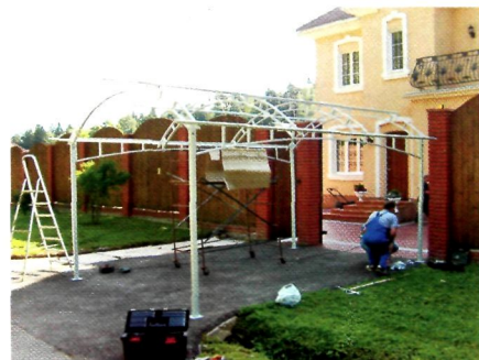
Элементы навеса собираются как конструктор
