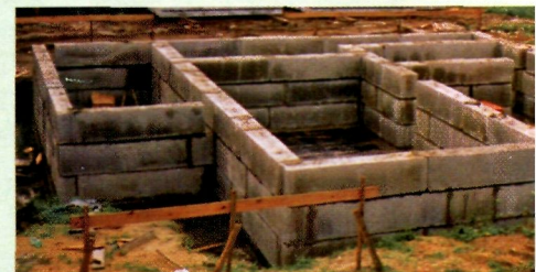
Каменные блоки, установленные поверх плиты фундамента
