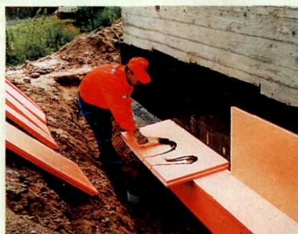
Теплоизоляция плитами ПЕНОПЛЕКС
