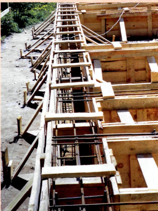
Ленточный фундамент. Опалубка и арматурный каркас
