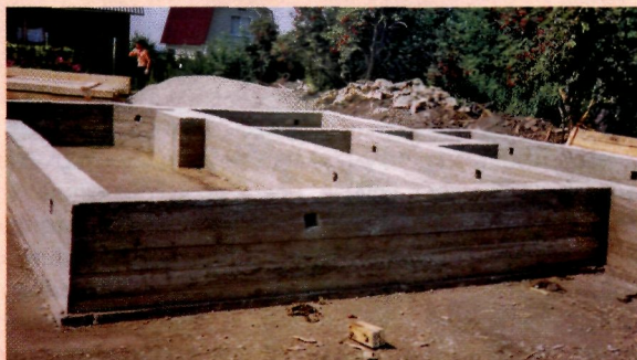
Укладка бетона по фундаментной ленте
