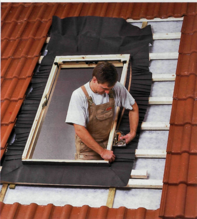
Окно GGL и комплект для гидро- и теплоизоляции BDX (Velux)
